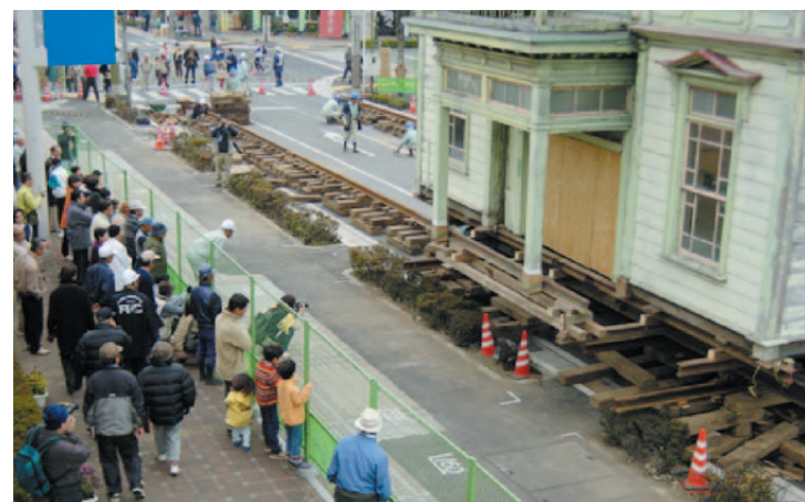
平成14年11月に市民の見守る中、建物ごとレールに乗せ100m曳き家移転してきました。
